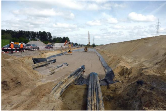
Chantier en cours - ELIA
